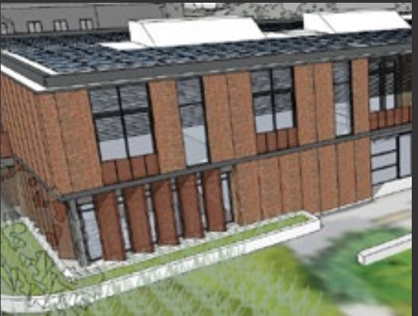
Fixed Exterior Slats
