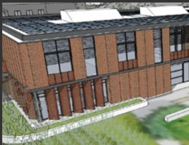
Fixed Exterior Slats
